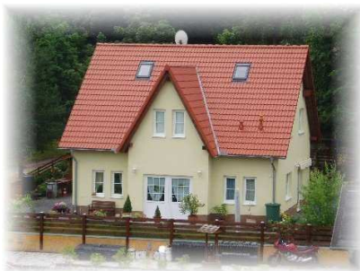
energiesparendes Einfamilienhaus in Ferch, Baujahr 2004 Auftragsumfang: schlüsselfertig, inklusive der Gestaltung der Außenanlagen
